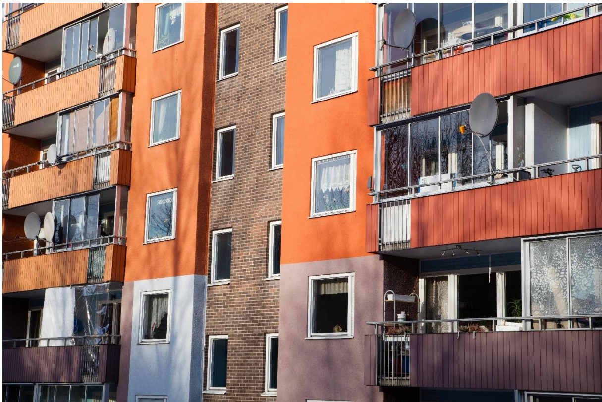
En soldränkt och färggrann fasad på ett av bostadshusen på Albyberget.
